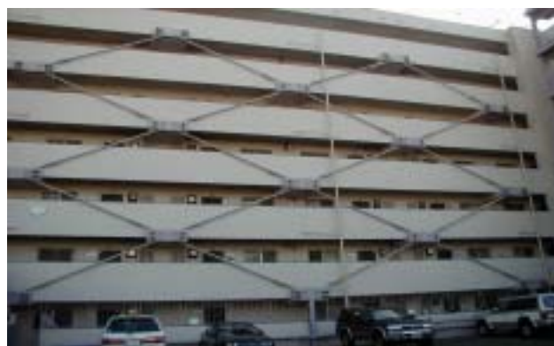
建物全景(北面)
