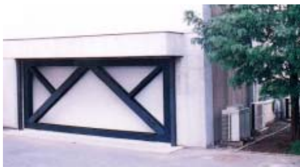
9号館 K型外部鉄骨ブレース工法
