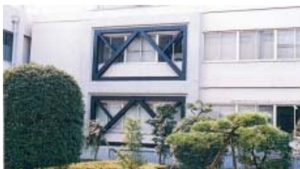
4号館 K型外部鉄骨ブレース工法
