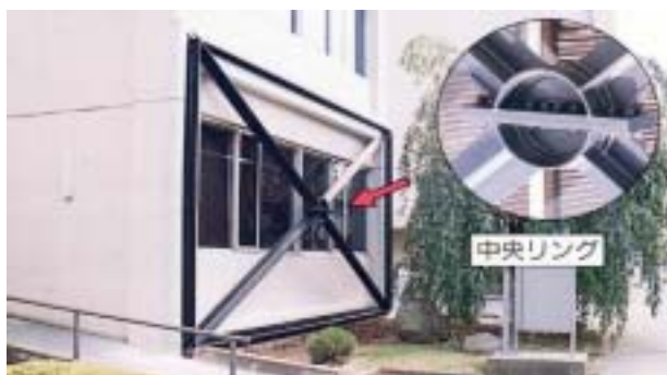
8号館 X型外部鉄骨ブレース工法
