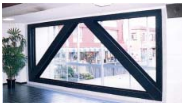
1号館 K型内部鉄骨ブレース工法
