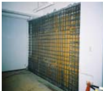
新設 耐震補強壁 施工状況
