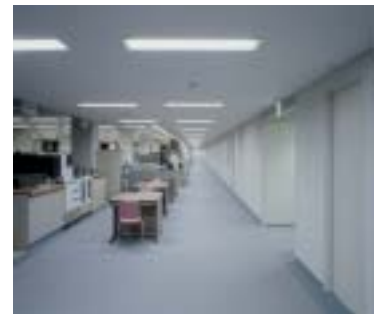
本館棟 補強後の内観 (増し厚壁補強)
