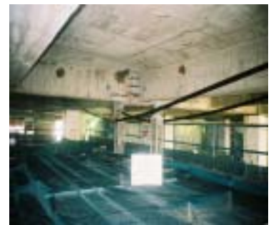
議場 PCケーブル補強 施工状況
