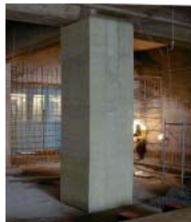
耐震補強完了状況
