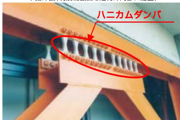
制震補強構面(鉄骨枠組ブレース頂部にダンパ組込)
