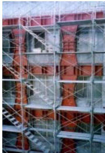
施工中(制震部材設置)
