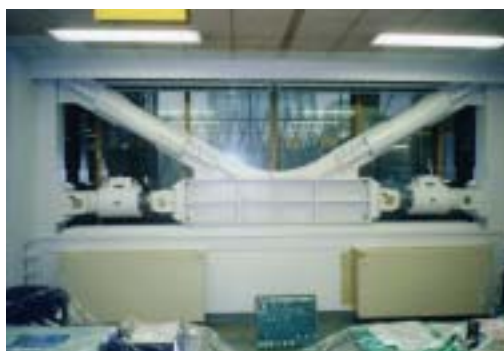
制震装置設置状
