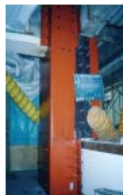
柱鋼板巻補強
