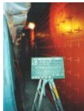
耐震壁鋼板補強
