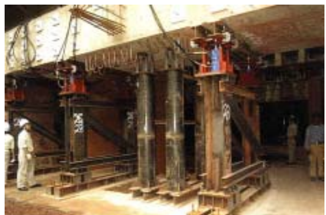
免震化工事状況 (ジャッキサポート)
