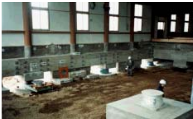
基礎部分の工事状況
