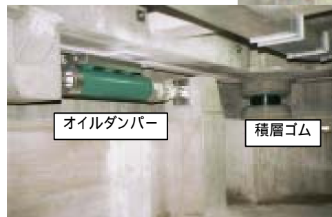
オイルダンパーと積層ゴムの取付完了状況 (地下1階柱頭)
