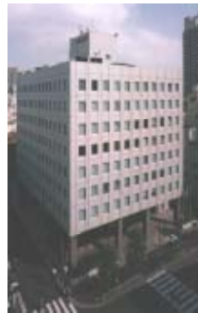
建物全景(地下1階が免震層)
