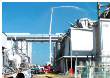
【東京電力福島第一原子力発電所3号機への放水】
