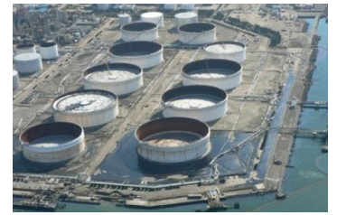
【津波により屋外タンク貯蔵所の配管が破損しタンク内の危険物が流出した状況】
