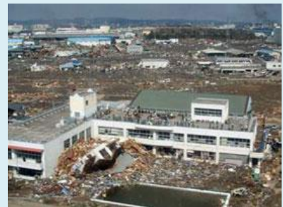
【中野小学校屋上の状況】
