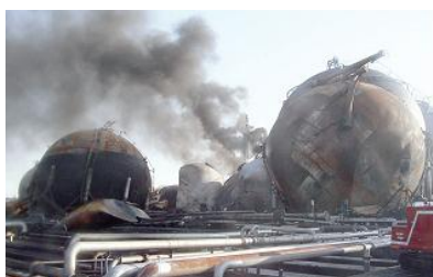
【火災により液化石油ガスタンクが倒壊(千葉県市原市)】
