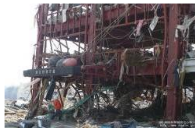
【南三陸町役場の被災状況】
