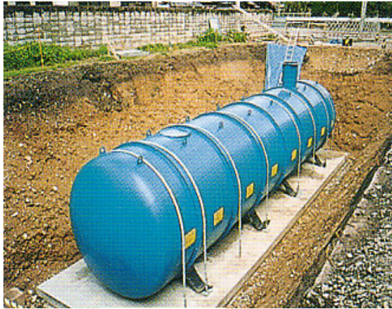
耐震性貯水槽
