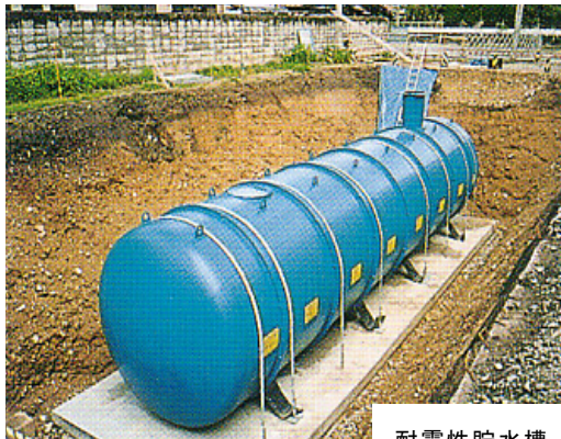
耐震性貯水槽
