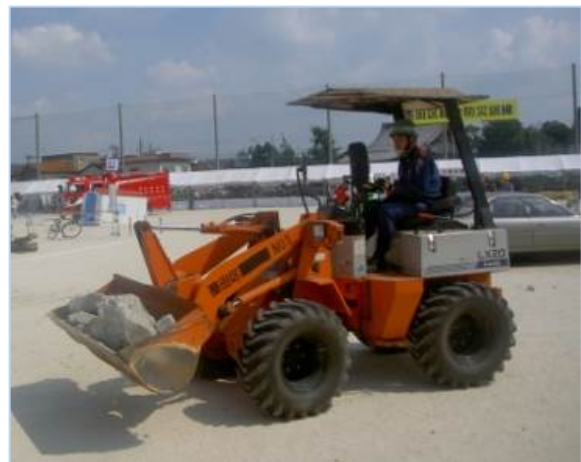
ホイールローダーによる瓦礫除去
