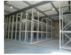
④屋内貯蔵所の移動式架台
