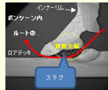
(2-4)溶接欠陥に起因する 割れ
