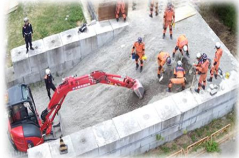
重機活用要領（提供：大阪市消防局）
