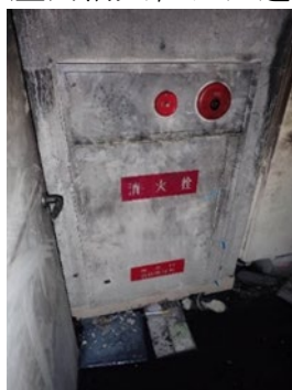
図 12 屋内消火栓設置状況
