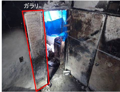
図3 待合室（出火室）への出入口扉（階段室側から撮影）
