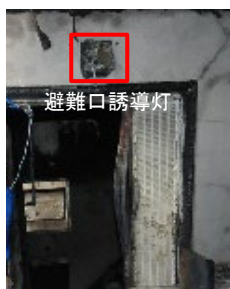
図 15 ③階段室出入口
