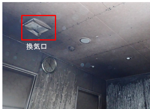
図6 診察室の天井及び壁
