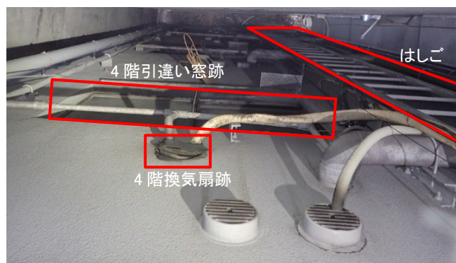
図9 診察室側外壁
