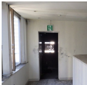
図10 5階空きテナント内部
