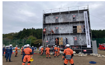
座屈倒壊建物救助訓練
