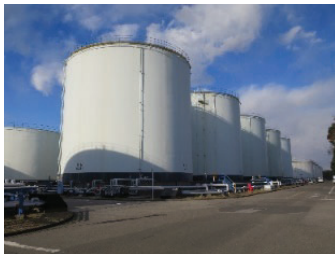
実証対象となるタンク
