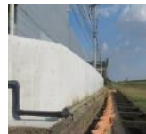
壁による敷地外への流出防止
