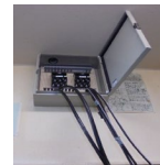
高い位置への配電盤設置
