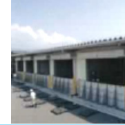
対策例： 止水板の 設置
