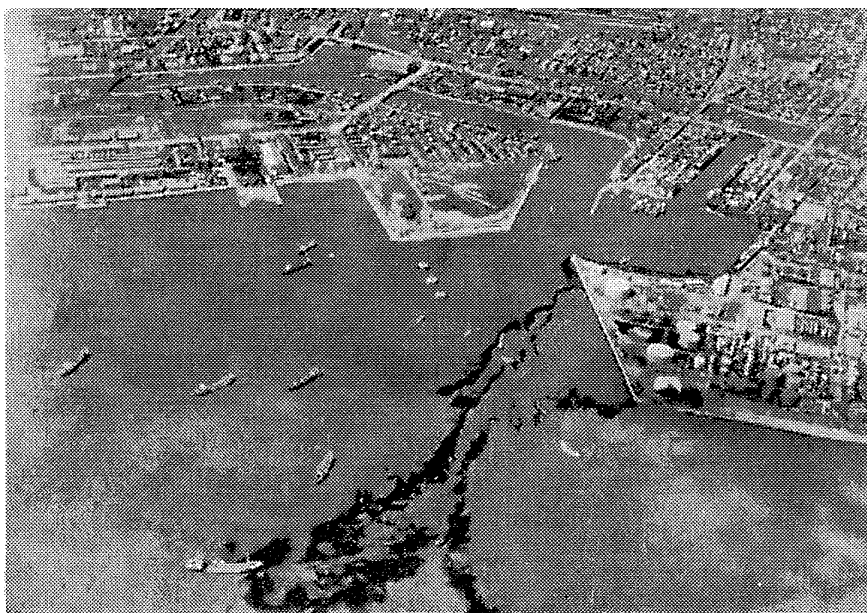
写真 2.2-1 変形した石油タンクから流出した多量の油（文献 2-1 より引用）
