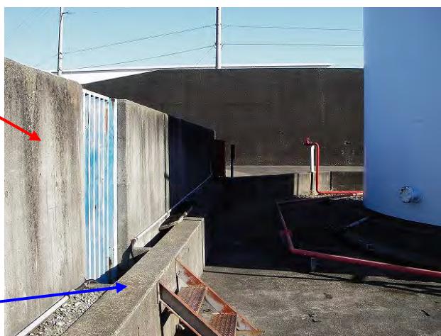
c) 防油堤 (内側から見た場合)
