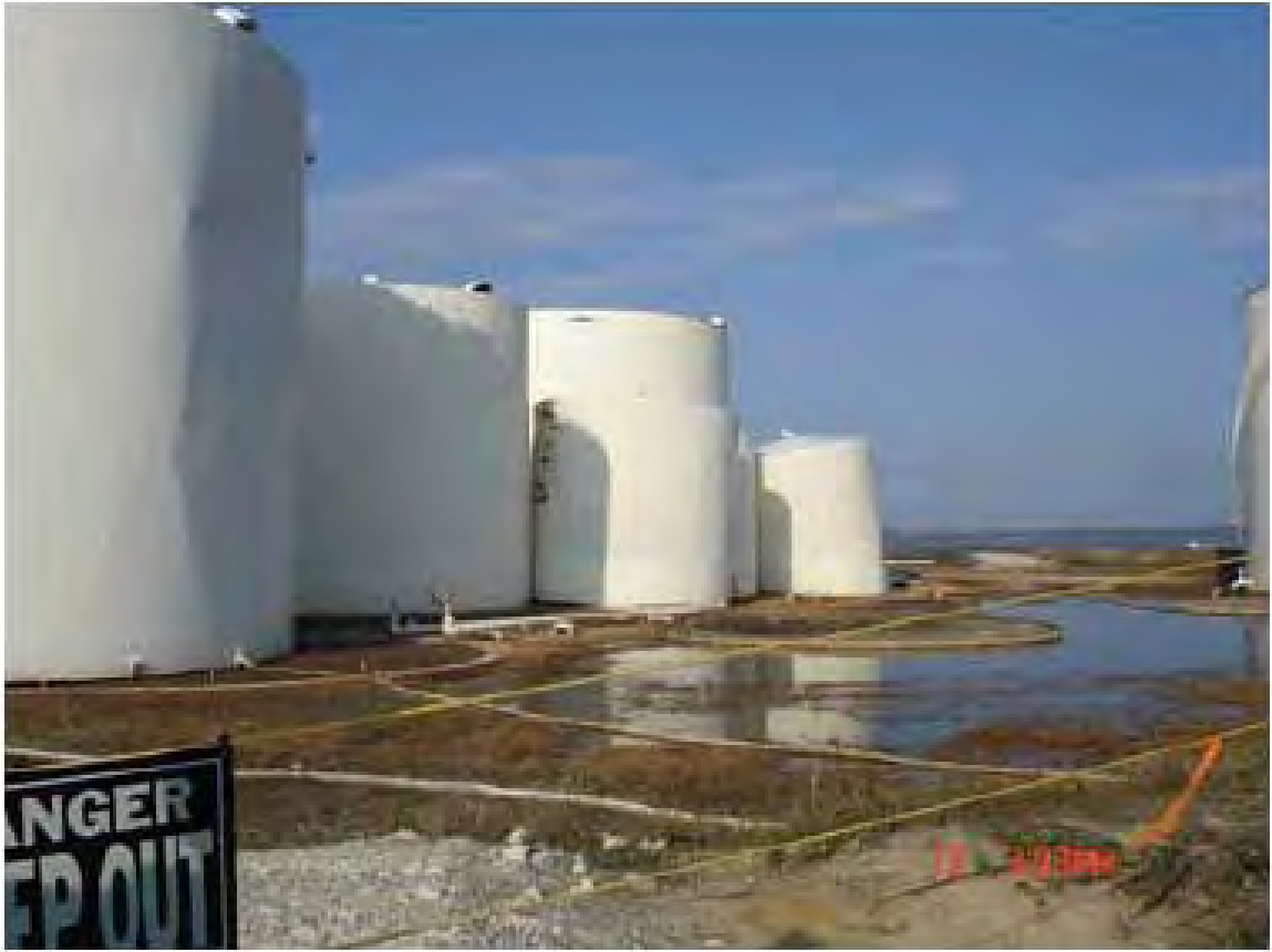
写真 2.2-5 漂流した石油屋外貯蔵タンク（文献 2-4 より引用）
