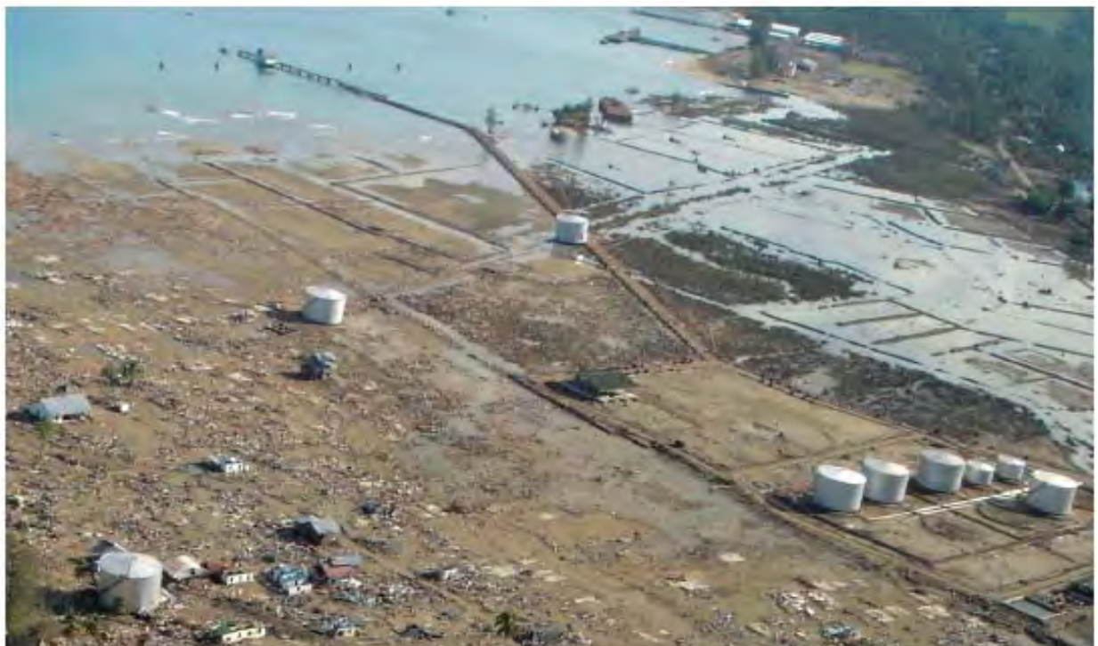
写真 2.1-7 津波によって漂流したタンクの様子（文献 1-6 から引用）
