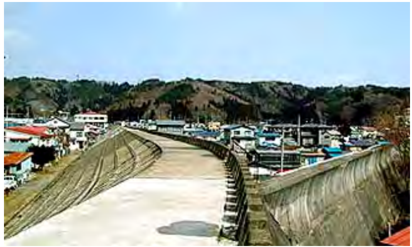
写真 2.3-2 田老町の防潮堤
