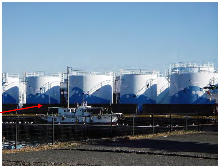
a) 石油タンク群
