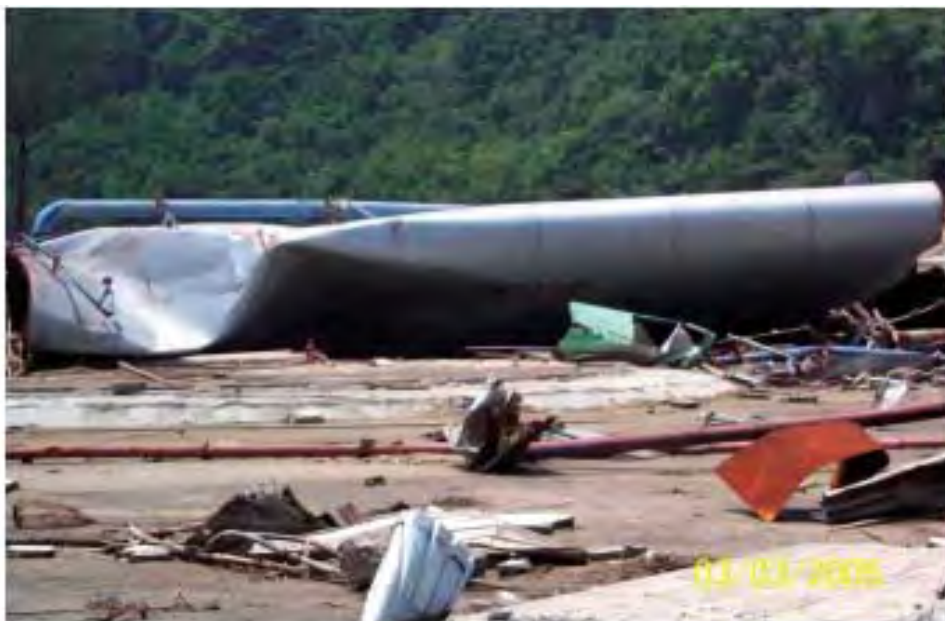
写真 2.1-5 No.1 タンクの被害状況（文献 1-6 から引用）
