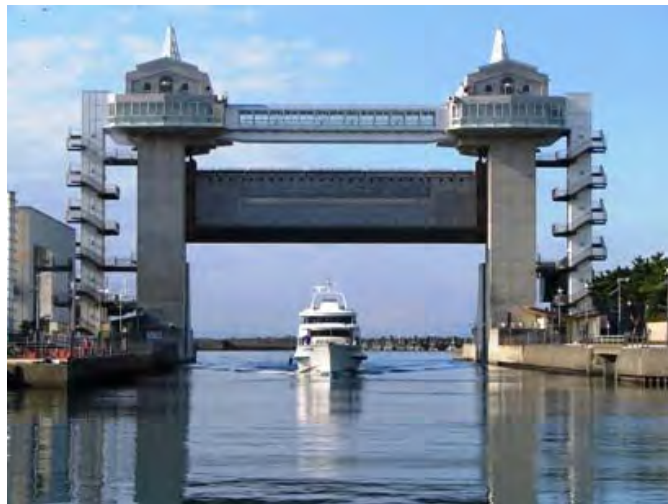
写真 2.3-3 沼津市の水門
