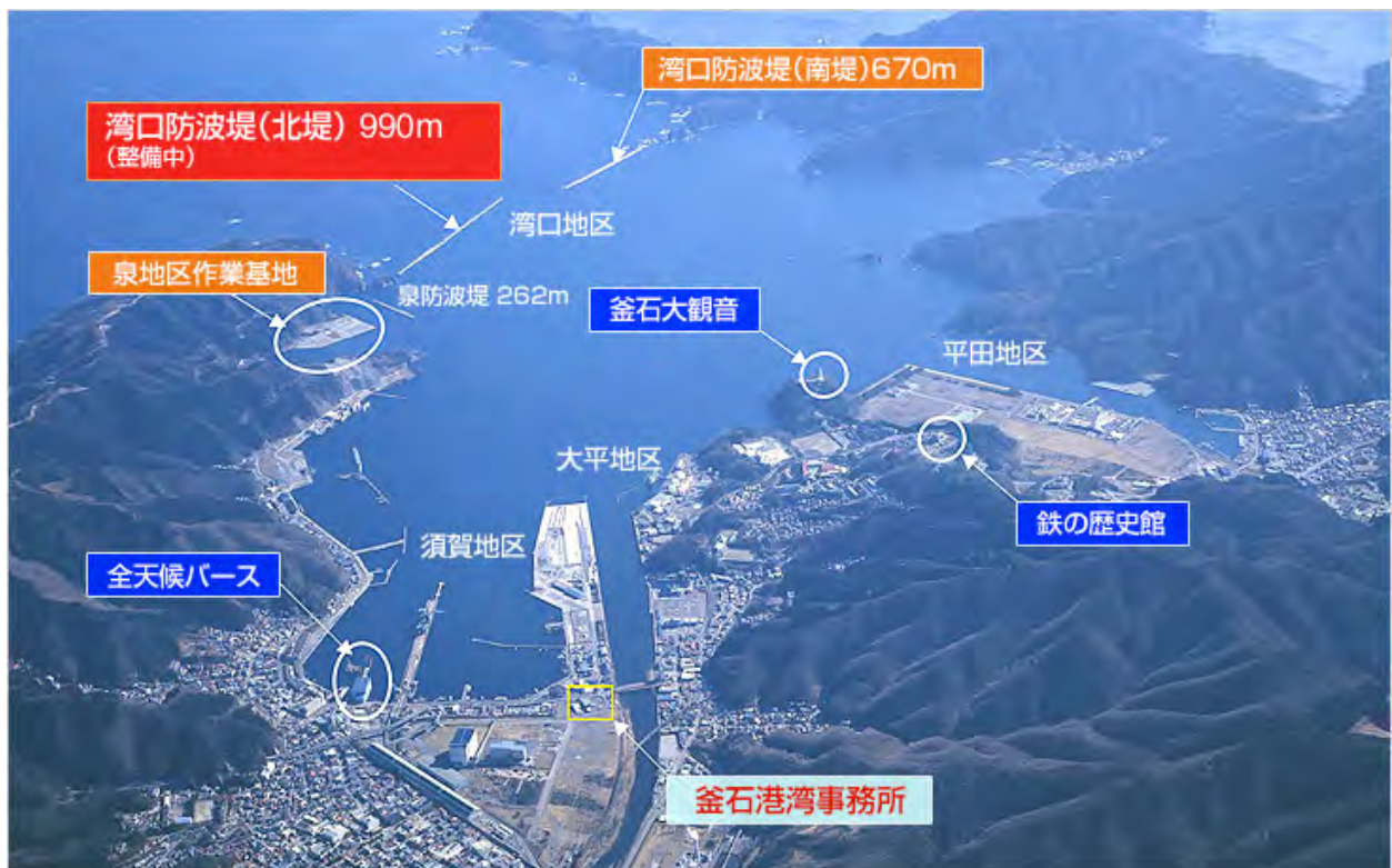
写真 2.3-1 釜石港の湾口防波堤
