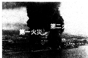
図-12 第2火災発生直後 (昭和39年6月16日 18:30頃 撮影：防衛庁)
