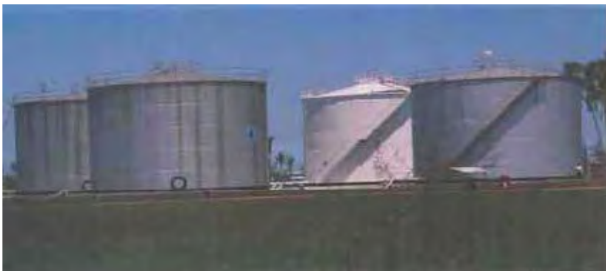
写真 2.1-8 オイルタンク群（文献 1-7 から引用）
