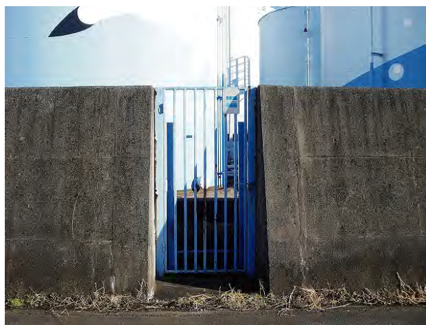
b) 人の出入りをしやすくしたり、外からタンクヤードを見やすくするための開口部 (外側から見た場合)
