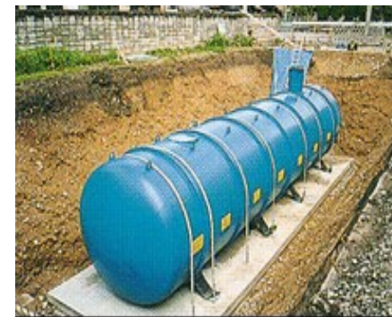
【耐震性貯水槽】
