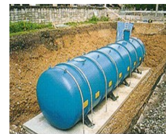
【耐震性貯水槽】
