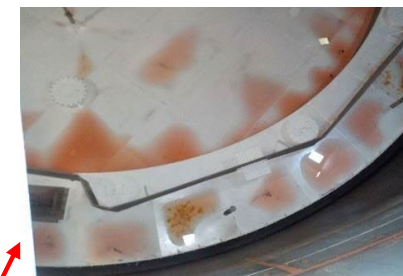
【内部浮き蓋上の滞油の状況】
