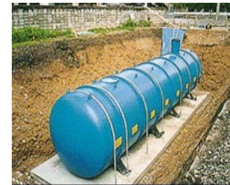
【耐震性貯水槽】
