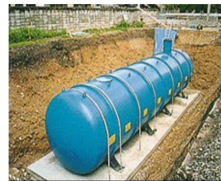
【耐震性貯水槽】
