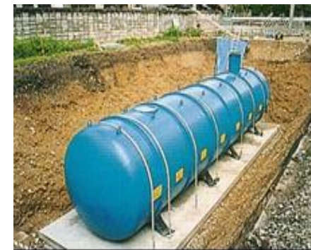
【耐震性貯水槽】
