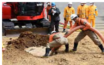
砂、泥、がれき等が吸引可能で、作業時間を飛躍的に短縮できる
