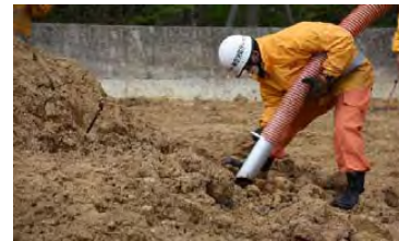
砂、泥、がれき等が吸引可能で、作業時間を飛躍的に短縮できる
