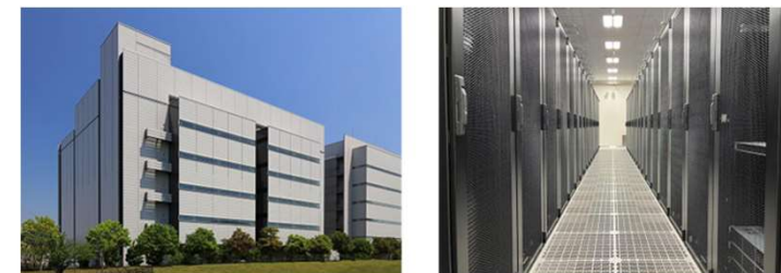
【データセンターの例】 （日本データセンター協会提供）
