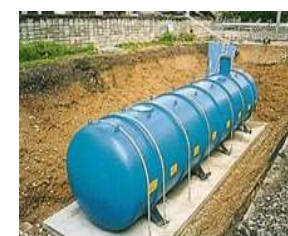
(耐震性貯水槽)
