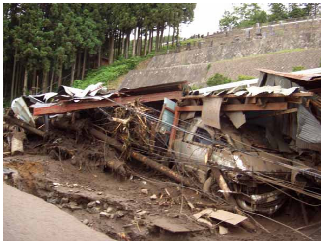
家屋や車の被害（岡谷市内）
