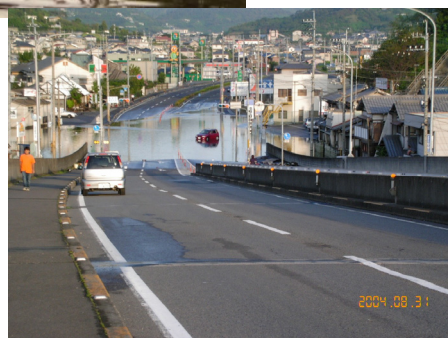
(出典)平成16年台風16号高潮災害(写真: 高松市提供)
