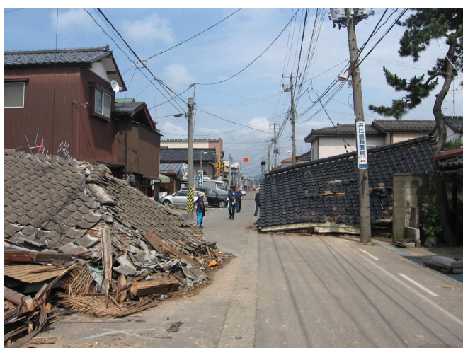
まちの被害状況（柏崎市内）
