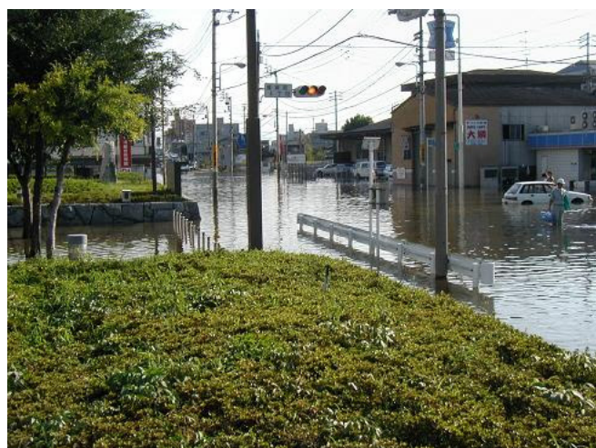
まち中での浸水状況（高松市）
