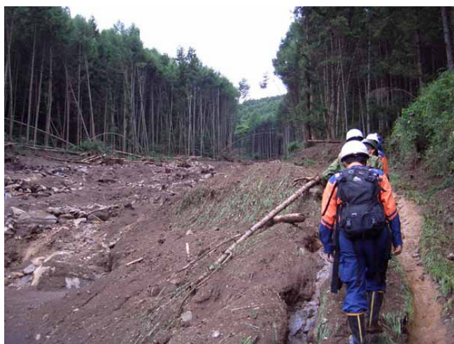
土石流が流れた跡（岡谷市内）
