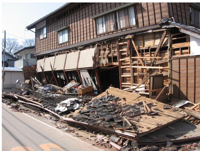
建物被害（輪島市門前町内）
