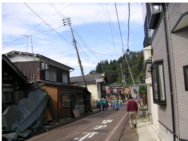
まちの被害状況（川口町内）
