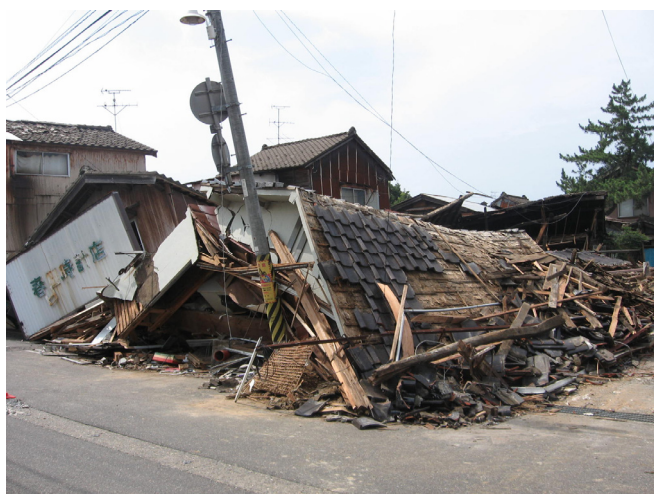
建物被害（柏崎市内）
