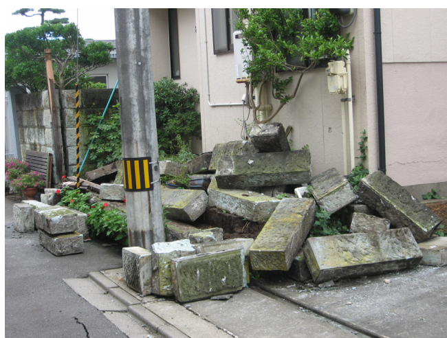
ブロック塀の倒壊（柏崎市内）
