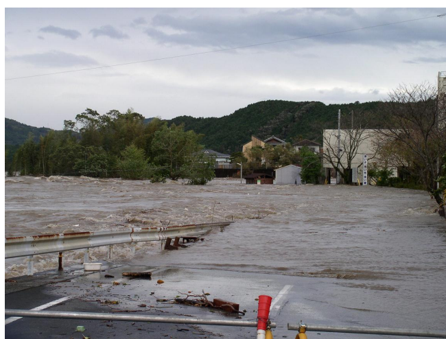
町道水没（平成 16 年 10 月越知町内）
