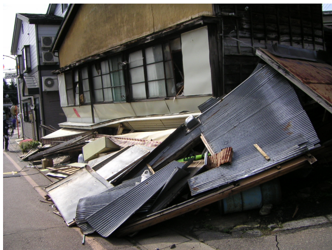
建物被害（川口町内）
