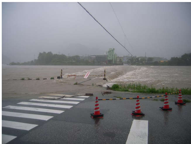
仁淀川沈下橋越水（平成 19 年 7 月越知町内）
