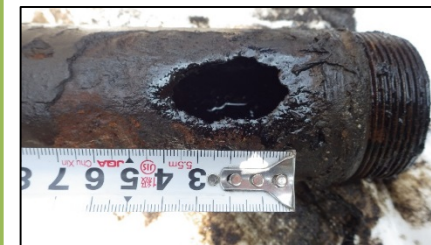
【腐食した埋設配管】
