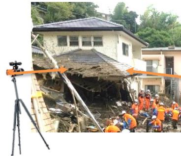
【土砂災害現場】
