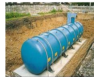
【耐震性貯水槽】
