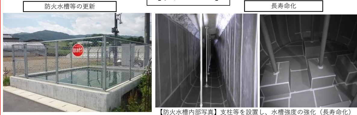
【防火水槽内部写真】支柱等を設置し、水槽強度の強化（長寿命化）
