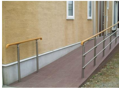
スロープの設置
