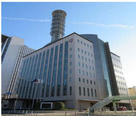
消防本部（消防署併設） (大阪市消防局)
