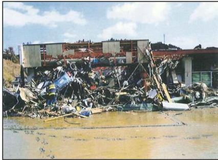
被災状況（津波浸水）
