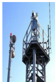
津波監視カメラ
