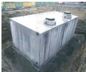
耐震性貯水槽
