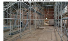
安全性向上のための改修
