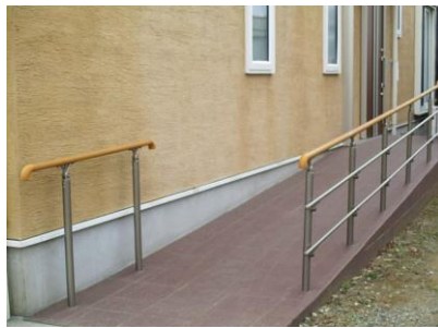
スロープの設置
