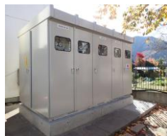
電源設備嵩上げ
