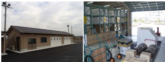
防災資機材等備蓄倉庫
