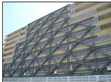
耐震補強工事
