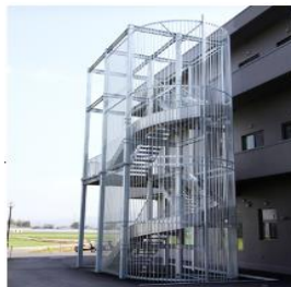
避難階段の設置
