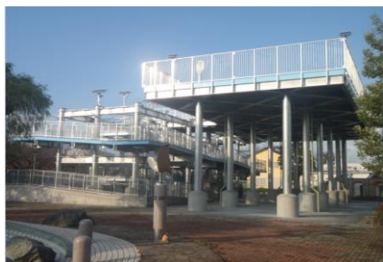
津波避難タワー
