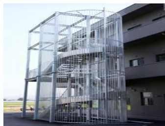
避難階段の設置
