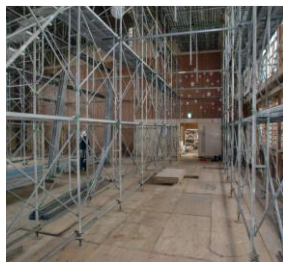
安全性向上のための改修
