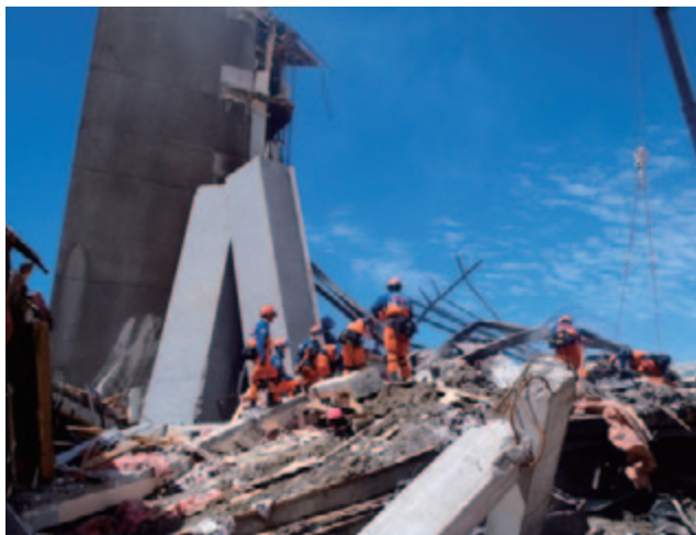
CTVビルでの捜索救助活動 (平成23年2月ニュージーランド南島における大地震災害)
