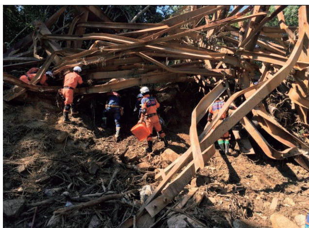
倒壊した建物での搜索活動 (堺市消防局提供)
