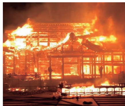
炎上中の正殿 （那覇市消防局提供）
