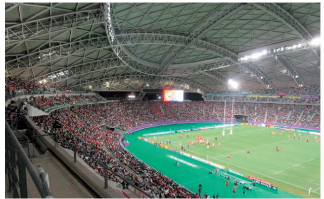
大分スポーツ公園総合競技場
