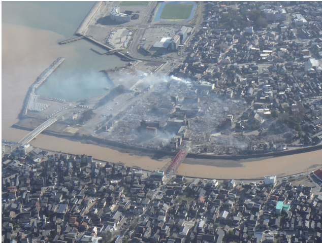
輪島市大規模火災現場周辺 （三重県防災航空隊提供）
