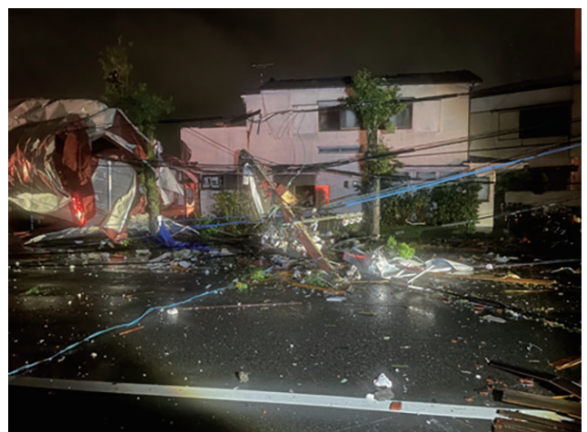
被害の状況2 (宮崎市消防局提供)
