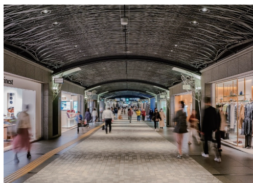
特集7-1図 緊急一時避難施設（地下施設）の例 （福岡市天神地下街）
