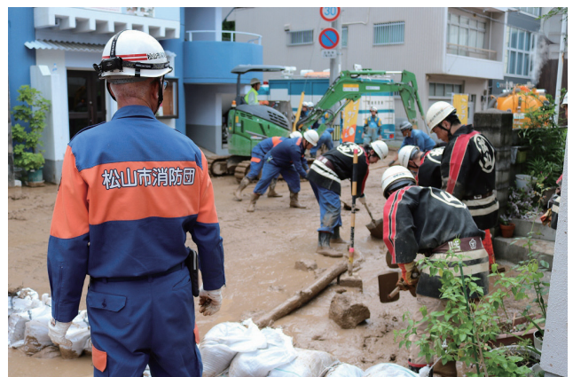
消防団による土のう設置作業の様子 (松山市提供)
