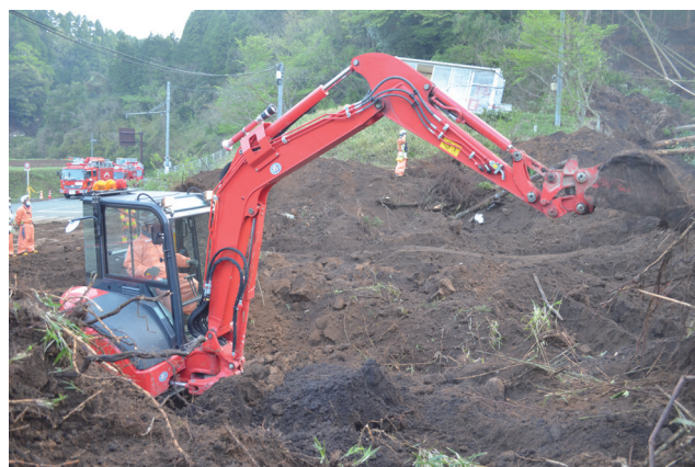
重機を活用した捜索・救助活動の様子 (平成28年熊本地震)
