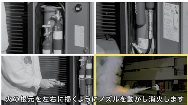
火の根元を左右に掃くようにノズルを動かし消火します
