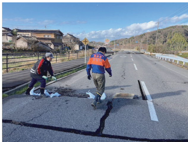
輪島市消防団による亀裂の入った道路補修の様子 (輪島市消防団門前分団員提供)
