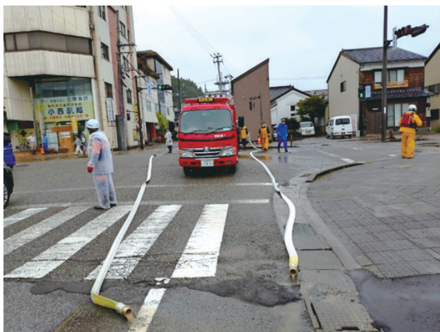
能登町消防団による冠水道路の排水作業の様子 (石川県能登町提供)
