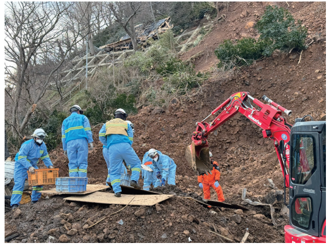
輪島市名舟町における重機による搜索救助活動
