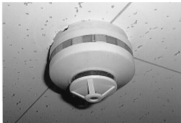
図1 三素子複合型センサー
