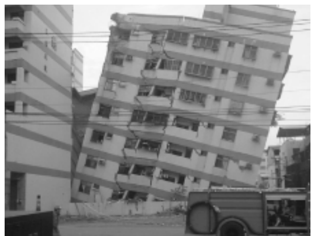
倒壊が進行する建物
