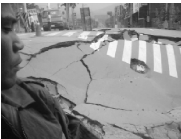
道路の破壊状況
