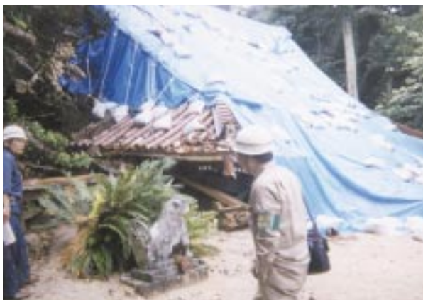
9月7日 地震と土砂崩れにより倒壊した神津島物忌奈命神社社殿
