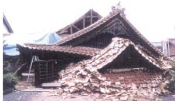
倒壊した出雲大社上道教会（鳥取県提供）
