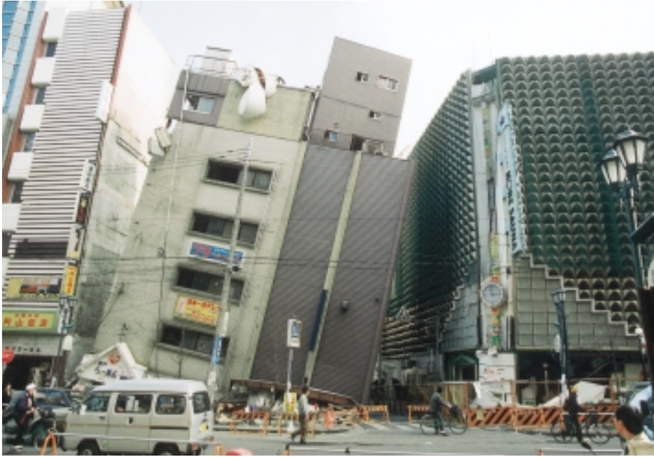
倒壊したビル
