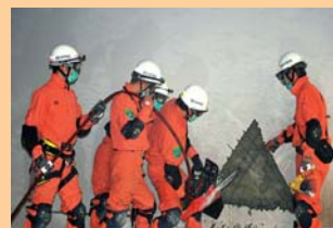
■ 表紙 高知市消防局 高度救助隊 崩壊建物内での コンクリート破壊訓練 (ブリーチング)
