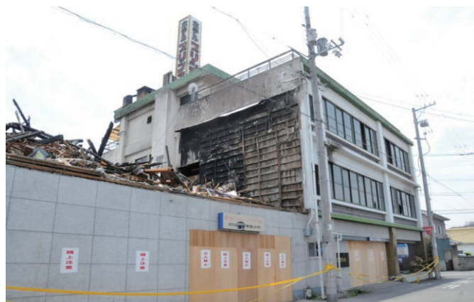
火災建物の外観
