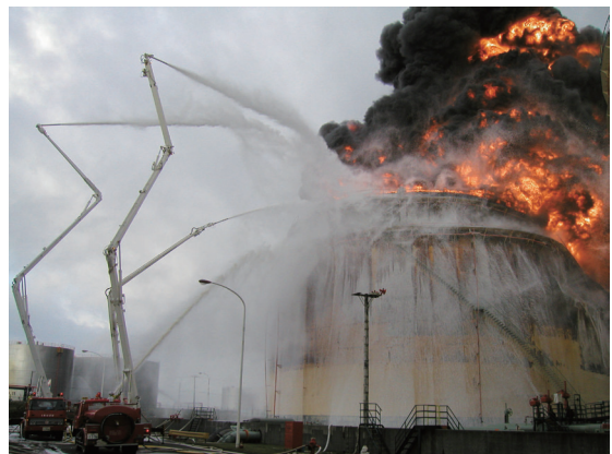
十勝沖地震でのタンク火災
