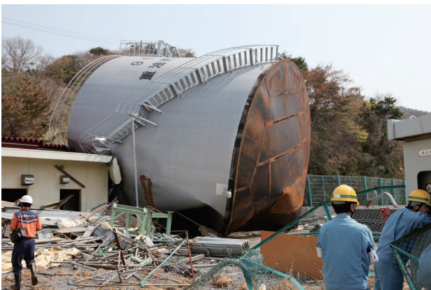
津波タンク被害
