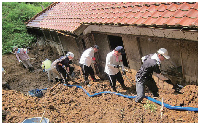
平成25年8月 ボランティアによる土砂の撤去作業 (写真提供：山口市社会福祉協議会)
