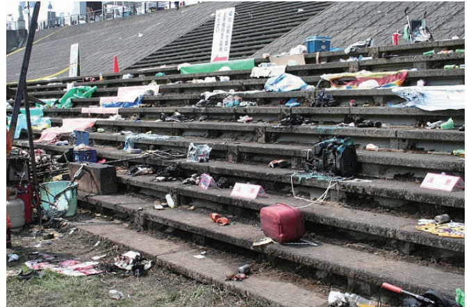
火災現場の現状（福知山市消防本部提供）
