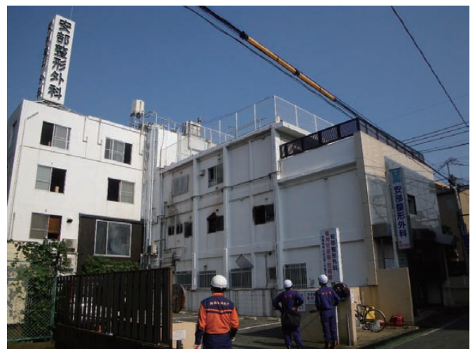
火災建物の外観
