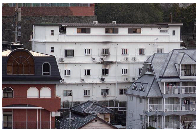
火災建物（中央白の建物）の外観
