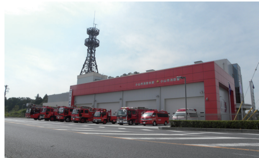
新消防本部庁舎
